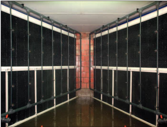
Die Düsengruppe sprüht Wasser auf die Vorderseite der Filterwand
