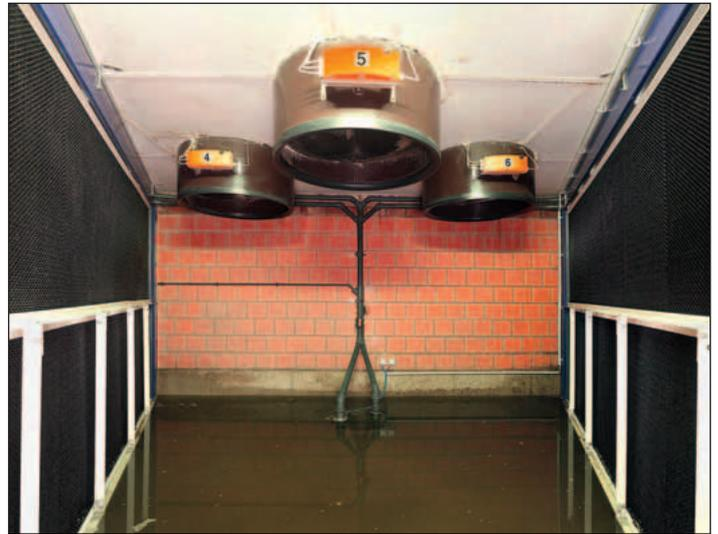
Rückwärtige Seite des Filters – Abluftkamine saugen die Stallluft durch den Filter
