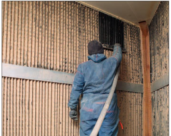
Reinigung des Filters mit einer Bürste
