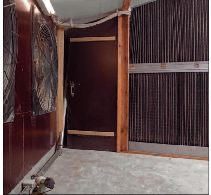
Rückwärtige Seite des Filters, Ventilatoren saugen die Abluft durch den Filter
